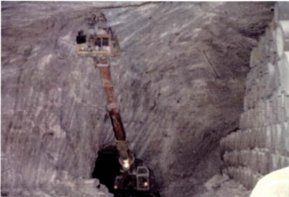
Abbildung 7: Fotos zur Position 3: Blickrichtung zum westliche Zugang der ELK 7/750 von der südlichen Richtstrecke nach Osten
