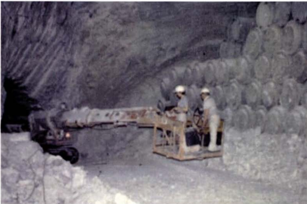
Abbildung 6: Foto zur Position 3: Blickrichtung zum westliche Zugang der ELK 7/750 von der südlichen Richtstrecke nach Osten
